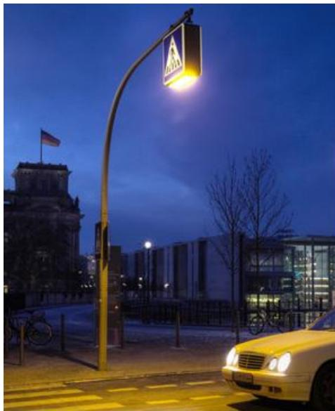
Рисунок 1.11 – Пример дорожных знаков 5.19.1, 5.19.2 с встроенными светодиодными светильниками уличного освещения
