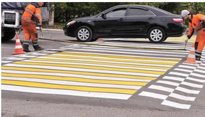
Рисунок 1.4 – Пример использования приподнятого пешеходного перехода
