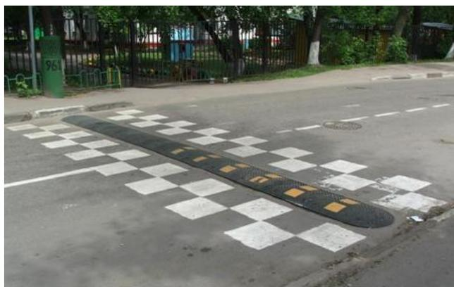
Рисунок 1.3 – Пример исполнения искусственной неровности сборно-разборной конструкции
